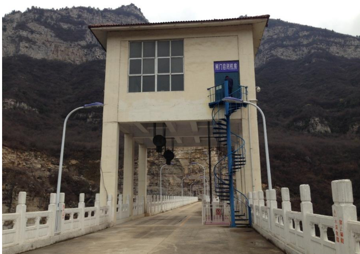
启闭机房（外景）
