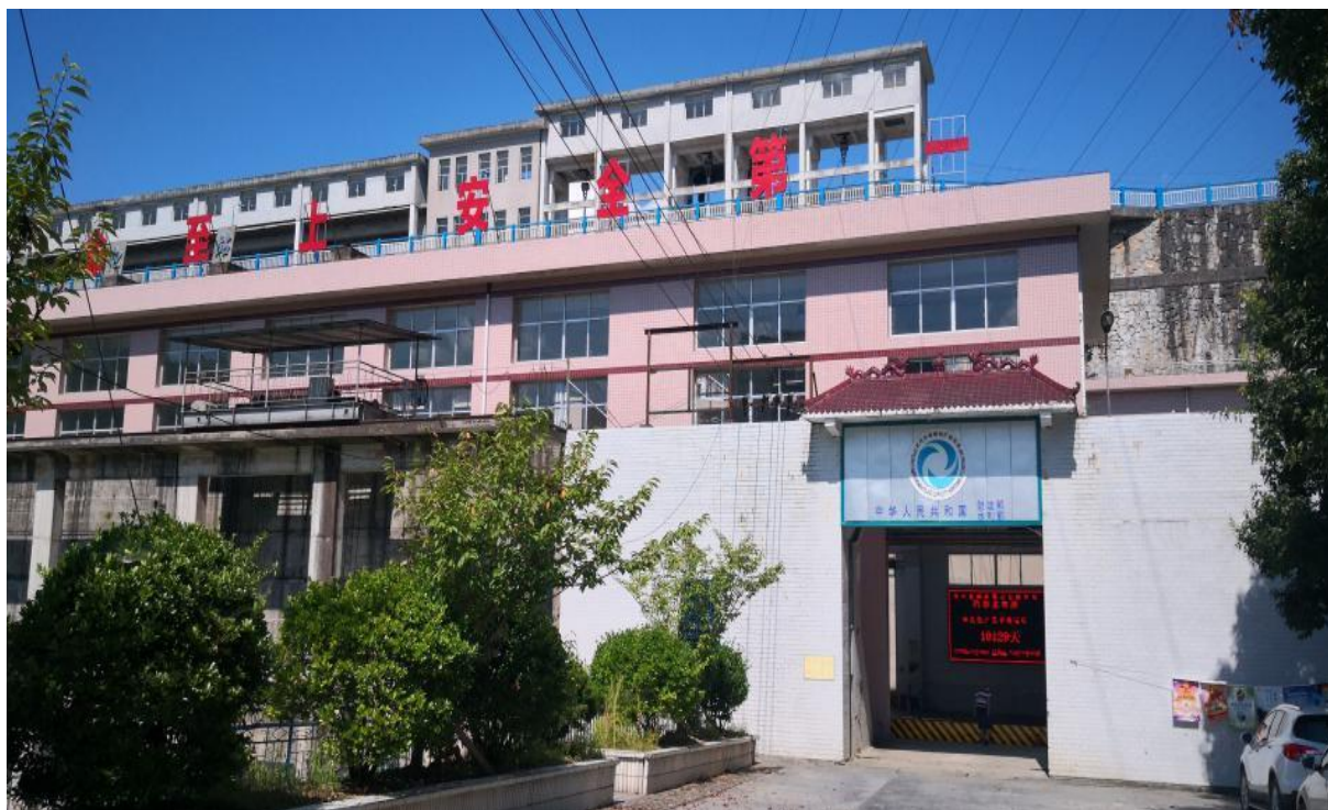
发电厂房外景
