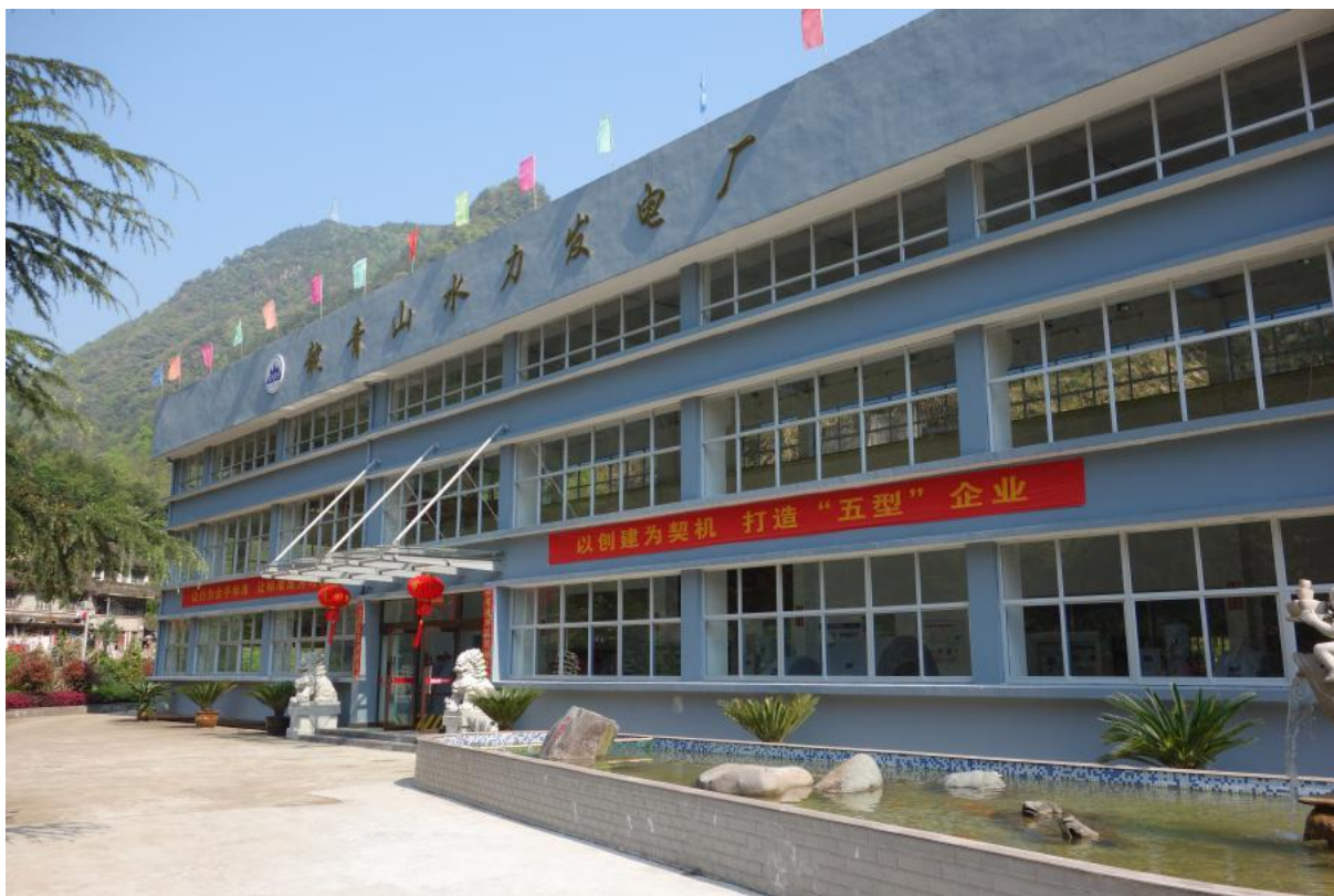
电厂厂房外景
