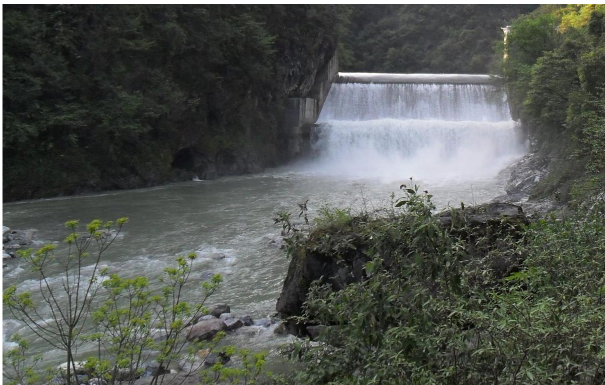
大坝及坝下河道
